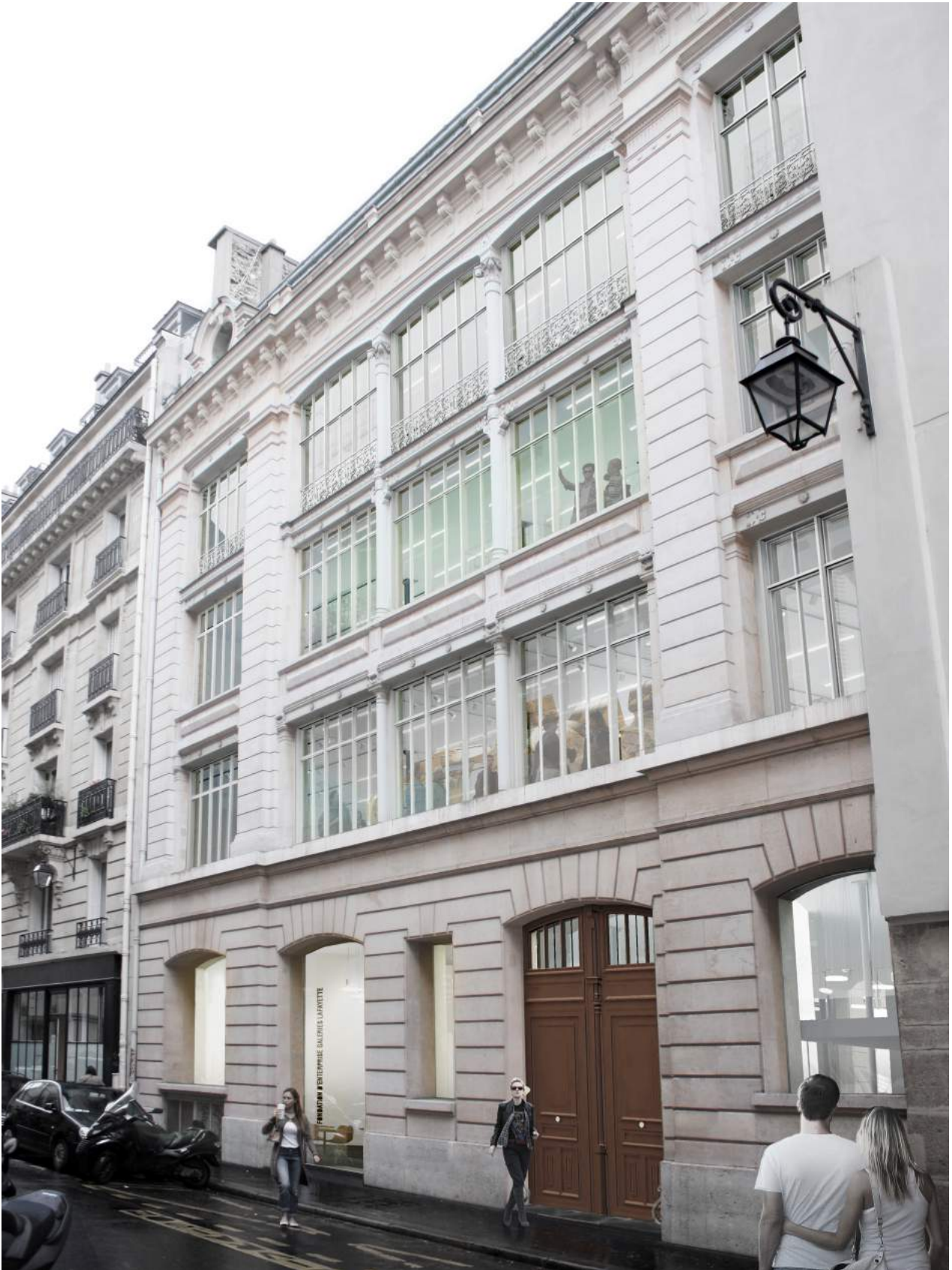
Façade du 9 rue du Plâtre
